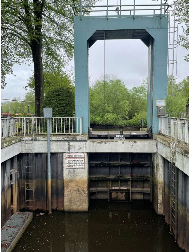
Schleusenkammer zur Wümme
