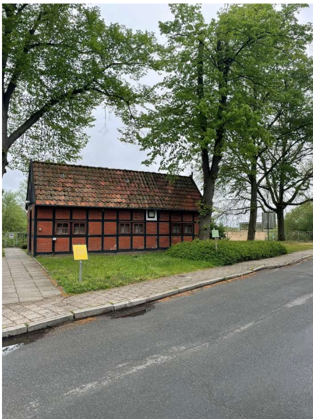
Schleusenwärterhaus und Freifläche
