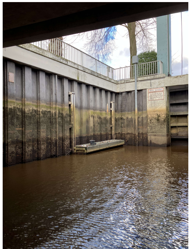
Schleusenkammer mit Schwimmsteg
