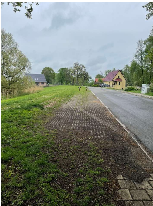
Befestigte Fläche an der Straße Am Lehester Deich
